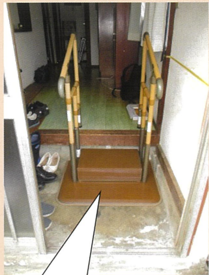
置き型の手すり
